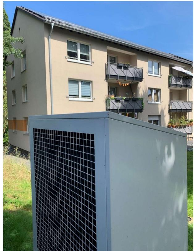
*Abb. 5: Häufige Kombination für Ein- und Mehrfamilienhäuser, Wärmepumpe und PV-Anlage*
